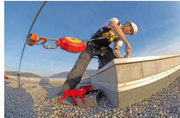
La ligne de vie câble est un support quasi horizontal (moins de 15° de pente) ou vertical, constitué par **un câble d'assurance** fixé à des ancrages fixes, sur lequel le point **d'attache de l'EPI coulisse** pour permettre à la personne ainsi assurée de se déplacer.
