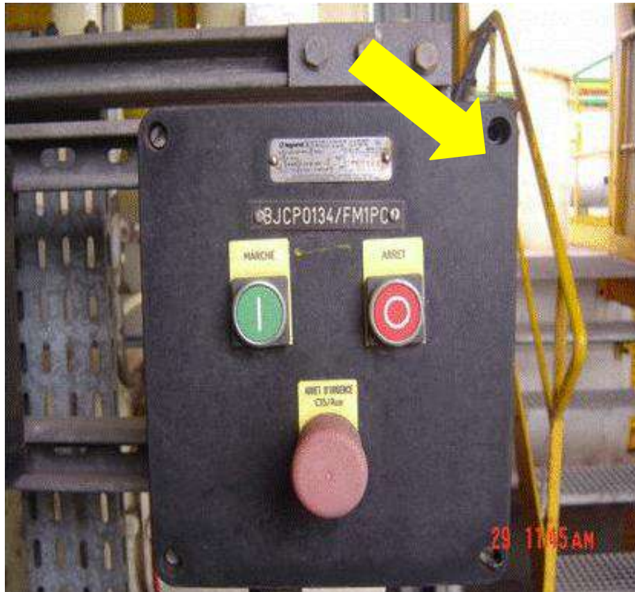
Manque vis sur le coffret
