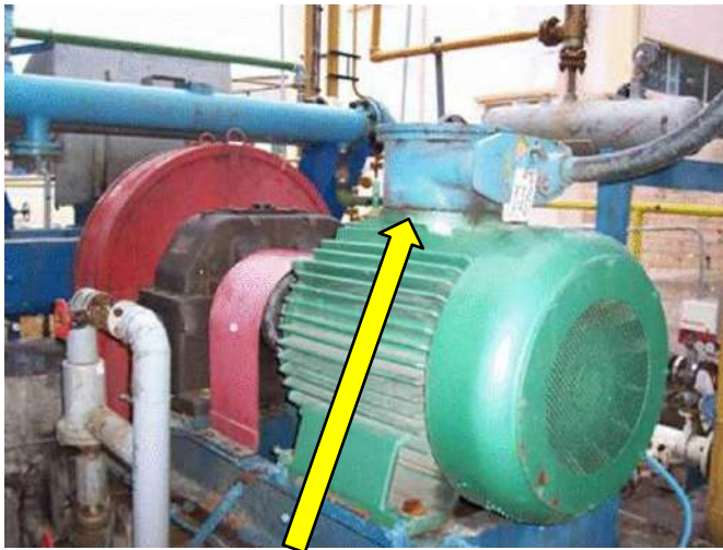
Boite à borne d'un moteur CEN montée et adaptée sur un moteur Jeumont « INTERDIT »
