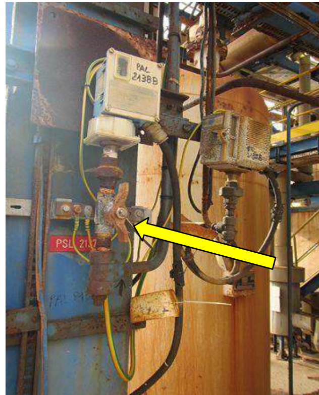
Vanne d'isolement montée entre l'enveloppe pressurisée et le pressostat normalement « INTERDIT »
